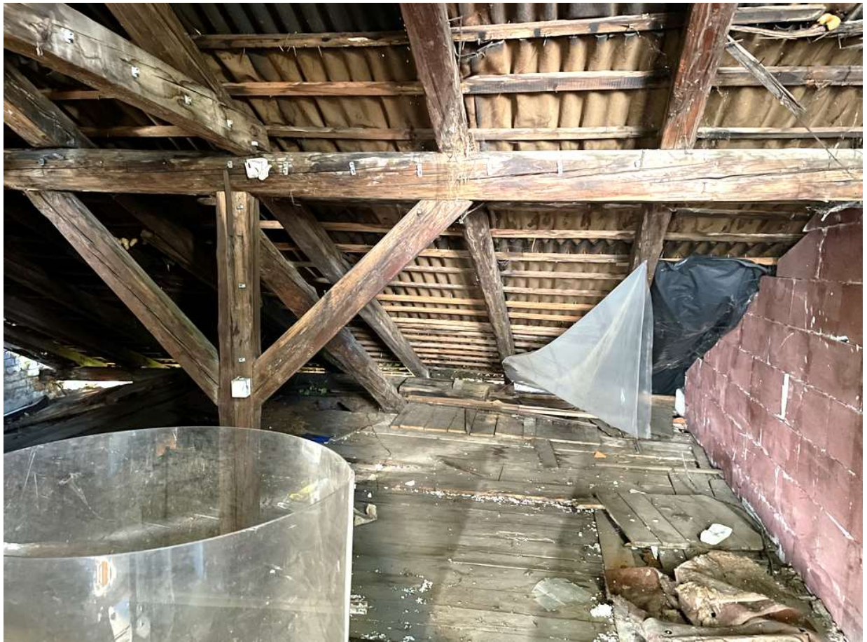
Slika 17. Drvena kosnrukcija krovišta - puni vez
