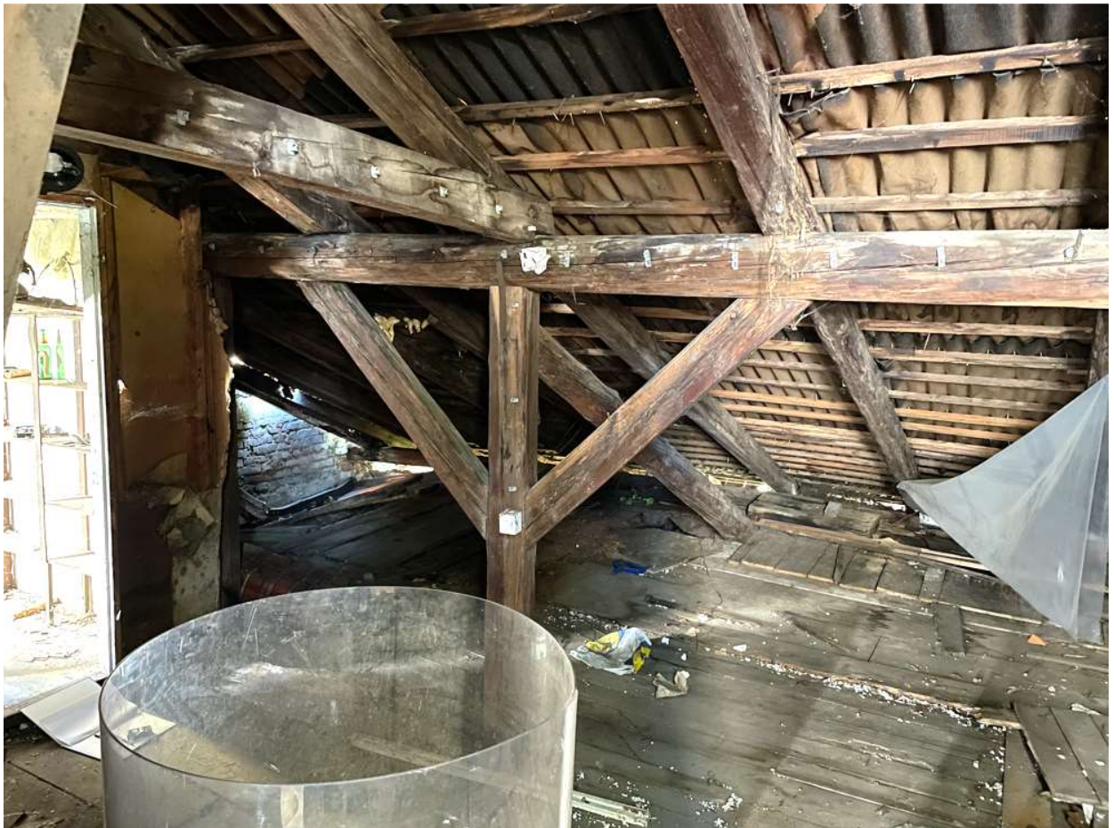
Slika 18. Drvena konstrukcija krovišta - puni vez
