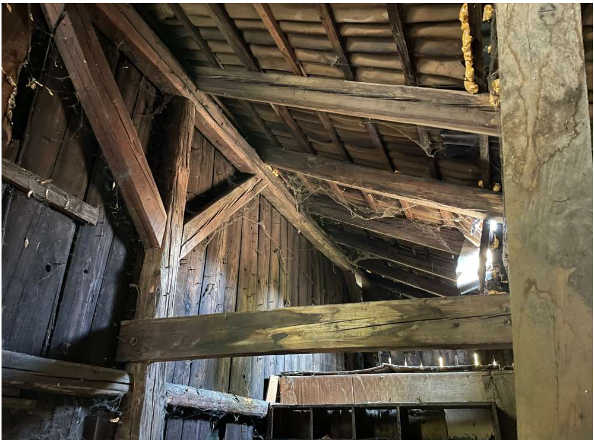
Slika 22. Drvena konstrukcija krovišta
