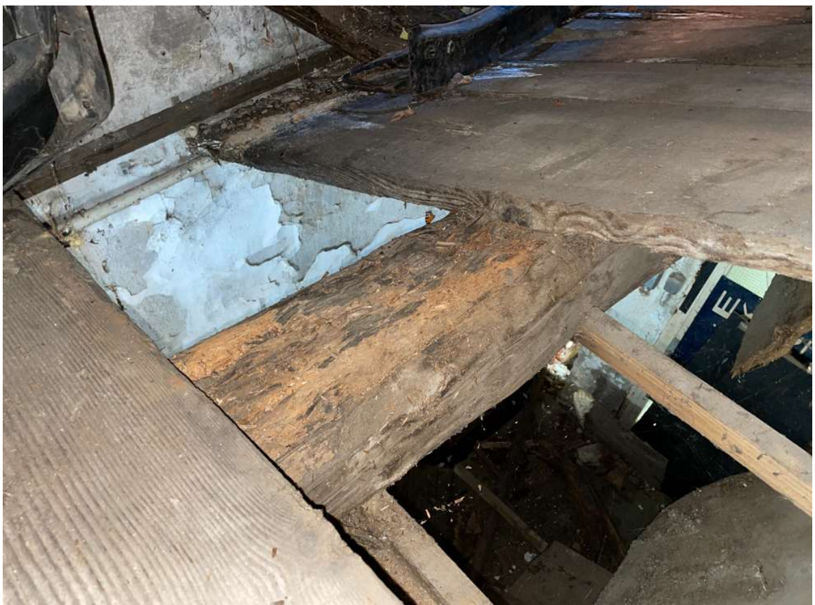
Slika 24. Rubna stropna greda u lošem stanju
