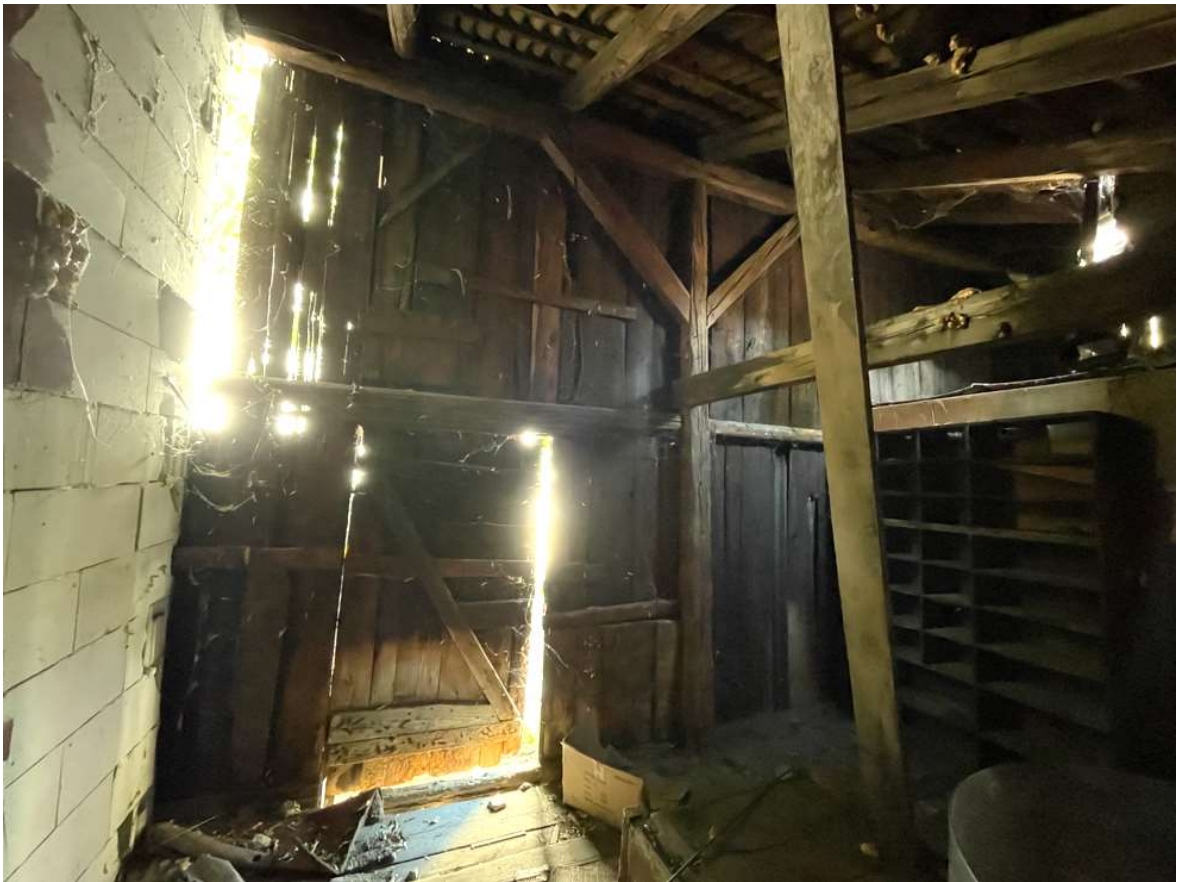
Slika 19. Drvena konstrukcija krovišta – zabat
